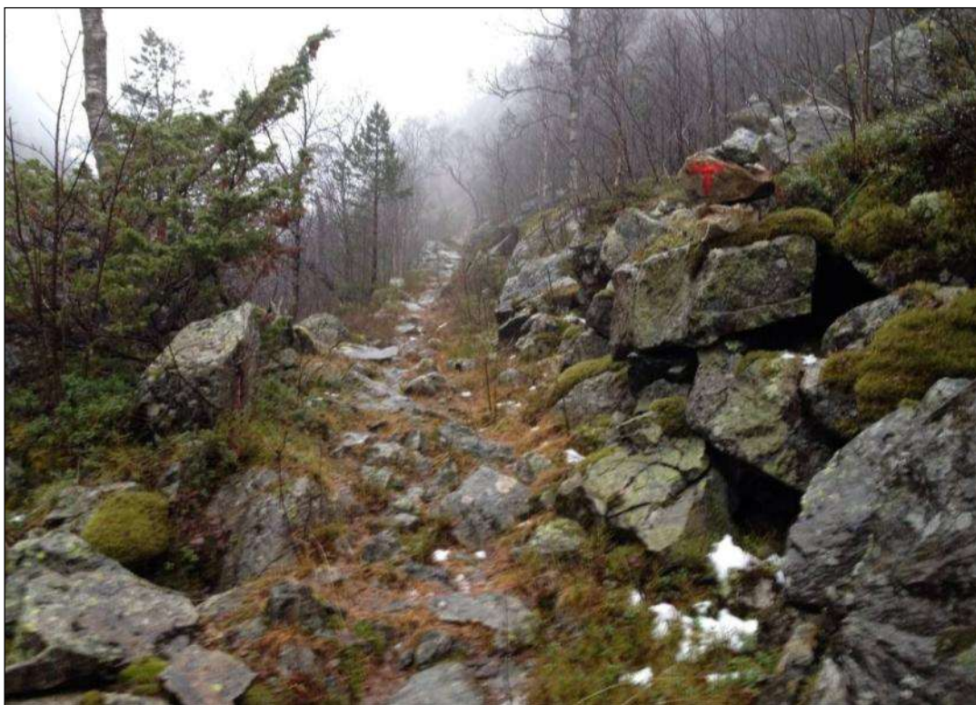
Figur 7.5. Eksisterende sti og driftevei gjennom blokkmark og skogsterreng. Foto: Knut Børge Strøm.
